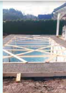
Abschluss der Installation
