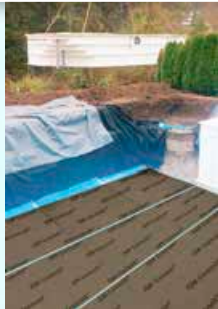
Verlegung der leitfähigen Folie
